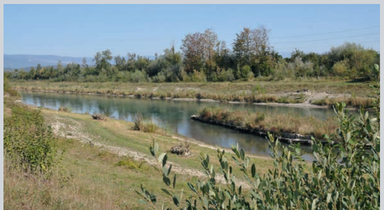
Unterwasserkanal, Bereich der Ausweitung. Bild: A. Lüscher.
