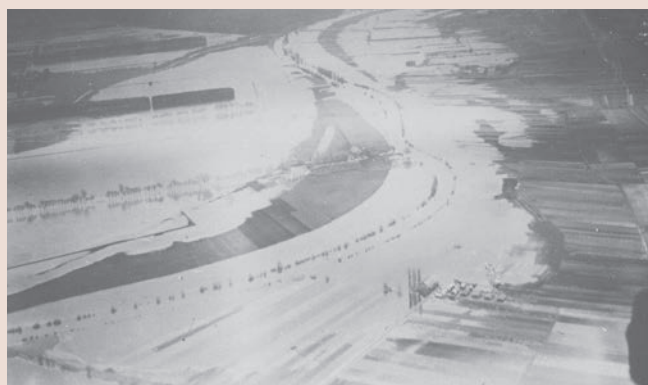
Überschwemmung 1944 vor 2. Juragewässerkorrektion (Foto: ETH-Bibliothek Bildarchiv)
